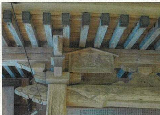
拝殿 向拝の木鼻・虹梁
